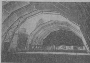
Рис. 3. Теннисный корт со складным тентовым покрытием по металлическим аркам (Италия)
